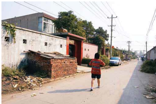
拆迁之前的石家庄市北高营村（摄于2006年10月）
